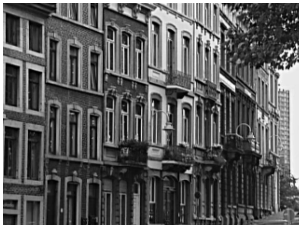
Abb.11 Die Häuserwand nach Anwendung der Unsharp Mask
